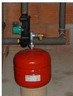
Slika 4.17 Izgled i šematski prikaz zatvorenog ekspanzionog suda sa membranom
